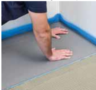
Fektesse az Isolecta lapokat az aljzatra. Rögzítse a lapokat csavarokkal/kapcsokkal.
