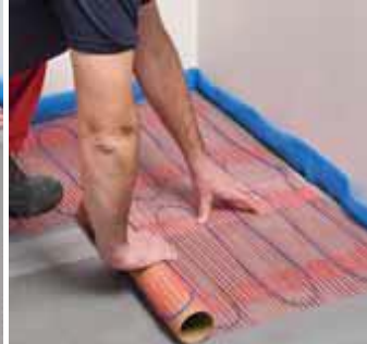
Telepítse a T2QuickNet, T2Blue vagy CeraPro fűtési rendszert.
